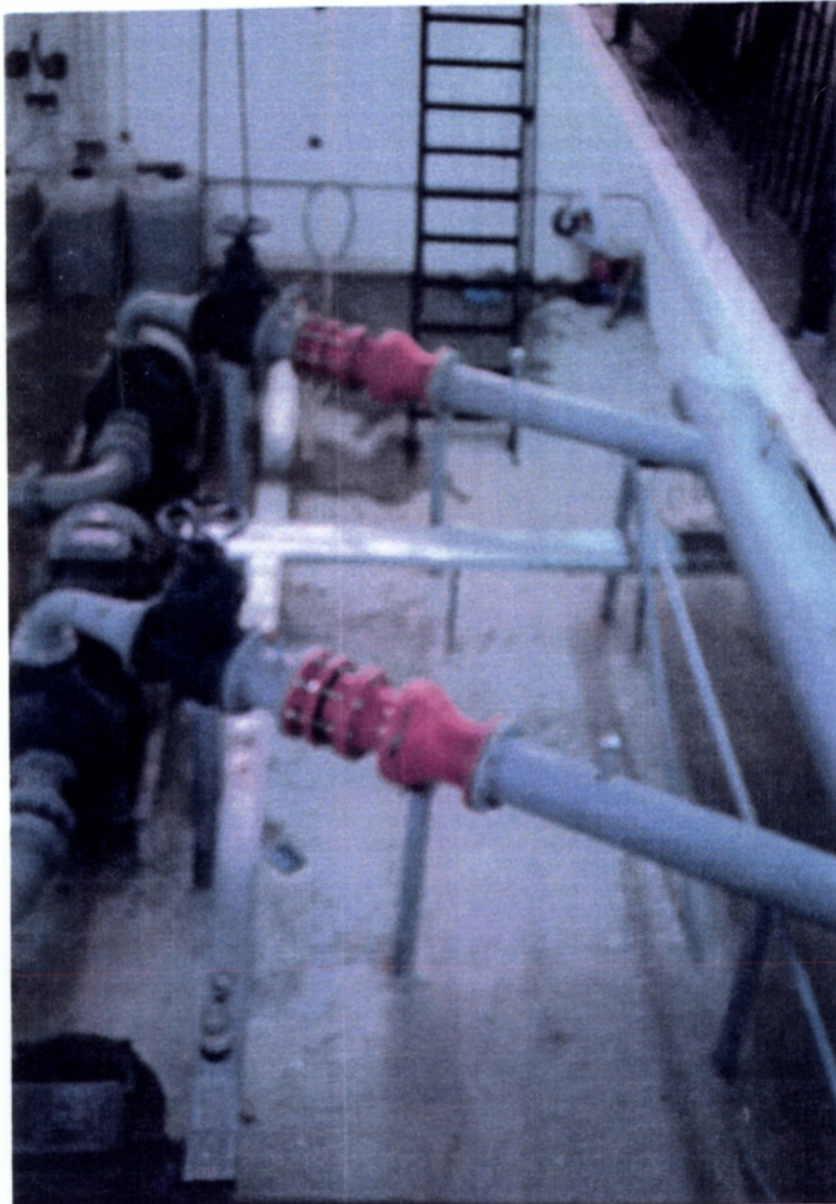
Αντλίες ανύψωσης νερού
