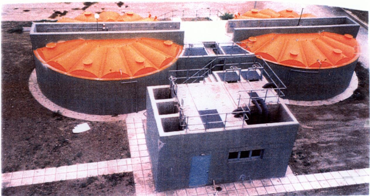
Εικ.16.6.2 Δεξαμενές Μεταπάχυνσης
