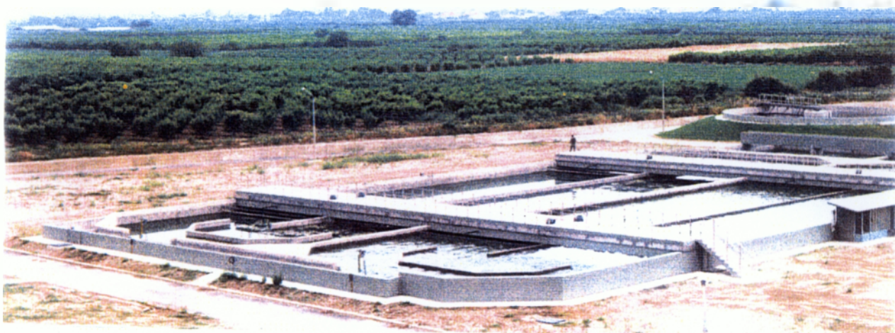
Εικ.16.3.1 Δεξαμενή Αερισμού
