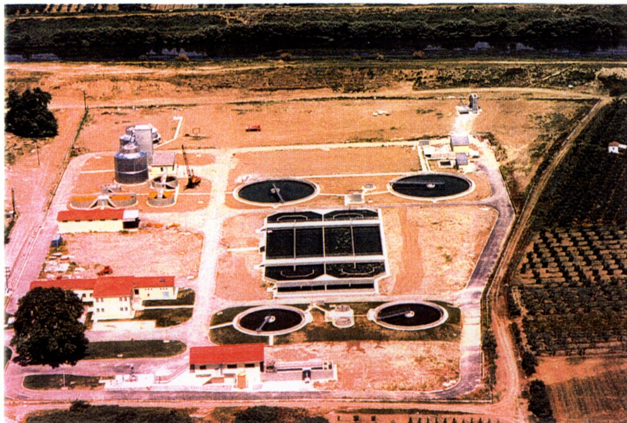
Εικ.12.1 Εγκατάσταση Επεξεργασίας Λυμάτων Βέροιας
