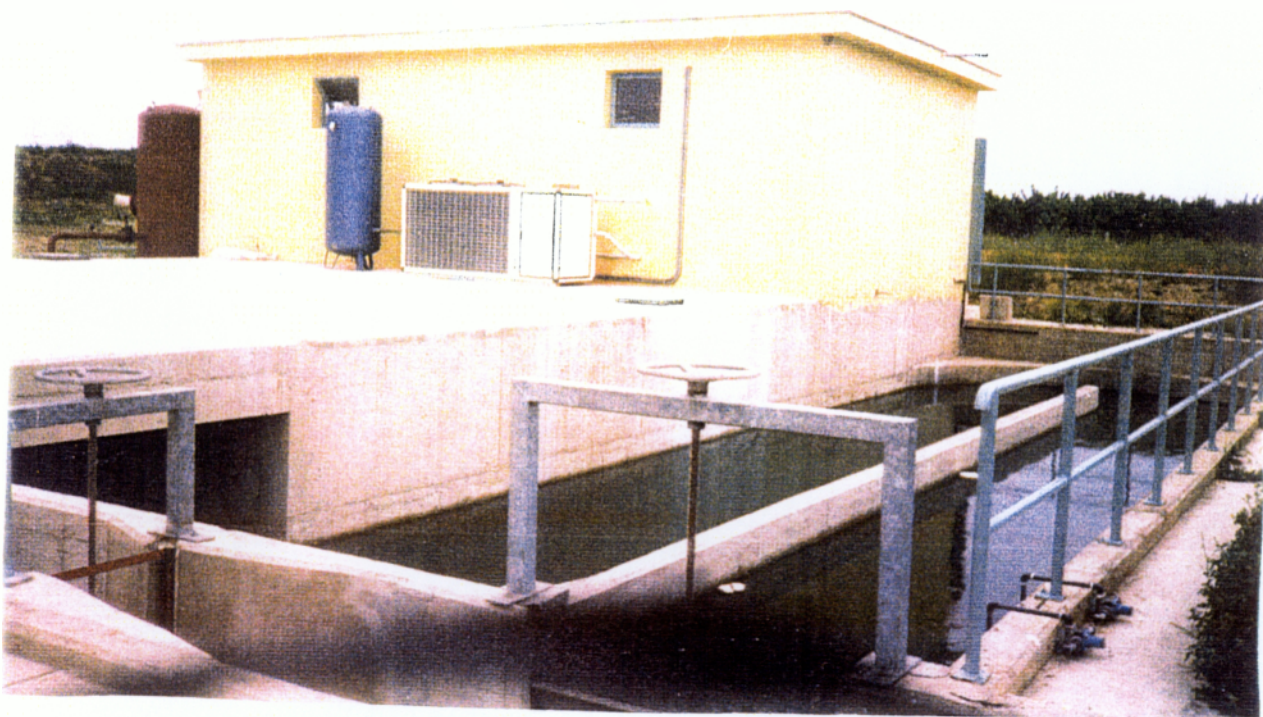
Εικ.16.5.1 Δεξαμενή Χλωρίωσης
