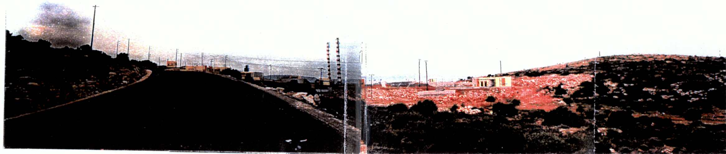
Φωτ. 1 : Οψη οικοπέδου με υπάρχουσα εγκατάσταση από οδό προσπέλασης προς Ανατολή.
