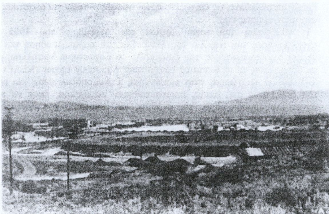
Φωτ. 21 Πανοραμική άποψη του φράγματος απόθεσης κατά το στάδιο της επίστρωσης στρώματος φυτικής γής.
