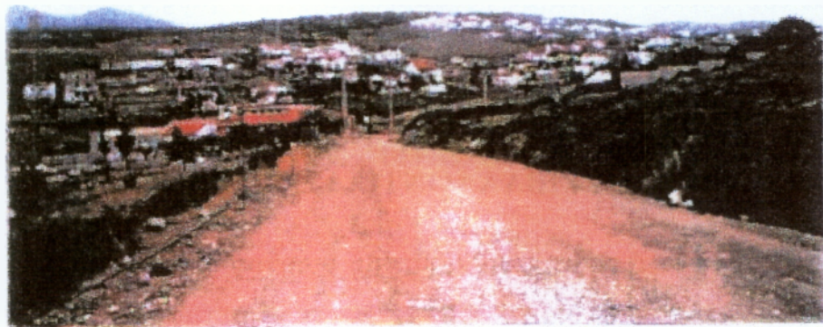
Φωτ.6 Αυθαίρετες κατοικίες στην ευρύτερη περιοχή των έργων.
