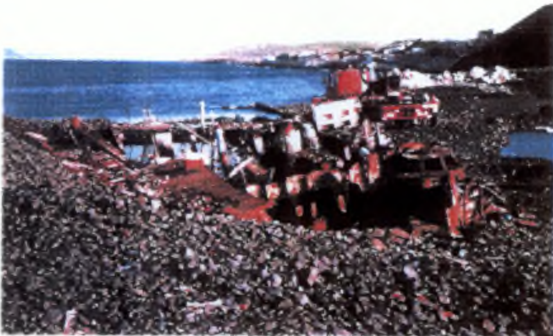
Φωτ. 18 Αποψη της θέσης κατασκευής του νέου εμπορικού λιμένα. Στο προσκήνιο φαίνονται οι εκβολάδες
