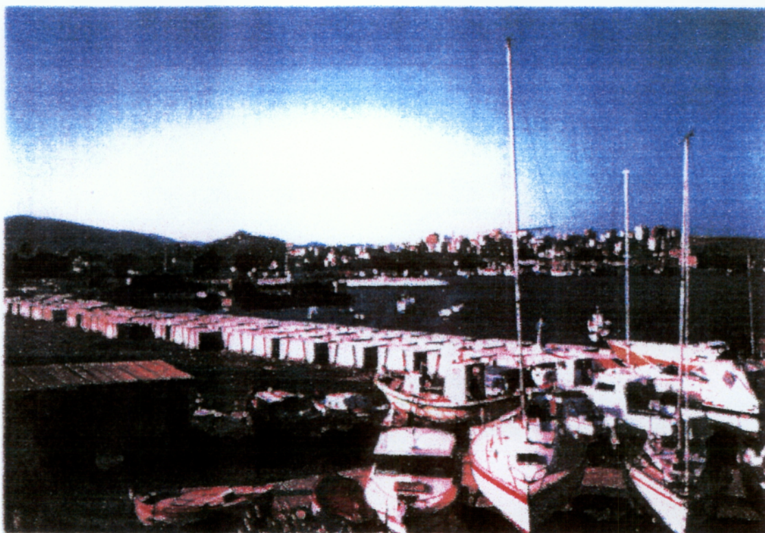
Φωτ. 16 Θέση κατασκευής νοτίου κρητιδώματος
