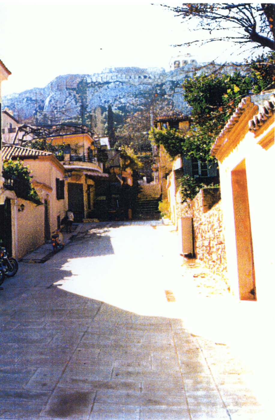
ΔΙΑΜΟΡΦΩΣΗ ΚΛΕΨΥΔΡΑΣ (ΕΡΓΟ ΣΕ ΕΞΕΛΙΞΗ 1994-95)
