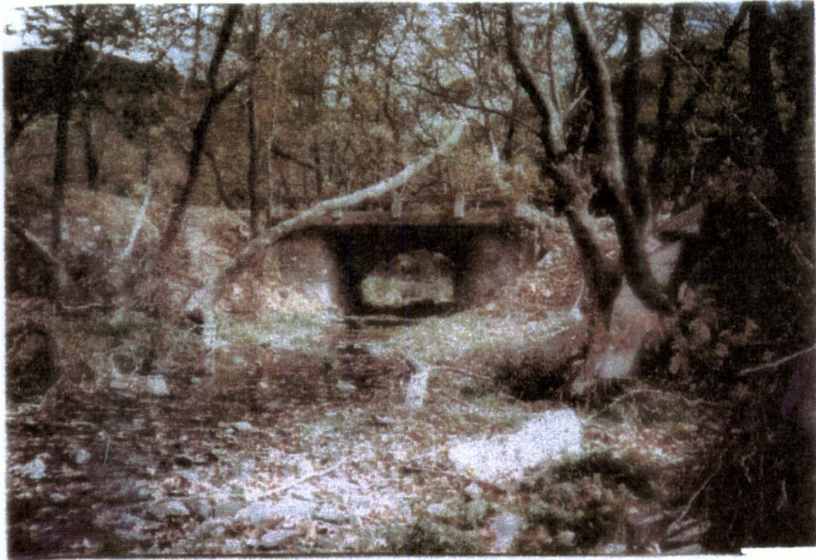
Φωτ 2.3.3. Ανάπλαση και ανάδειξη γέφυρας "Καμάρας" στον παλιό επαρχιακό δρόμο «Μ. Παναγιά – Γομάτι».
