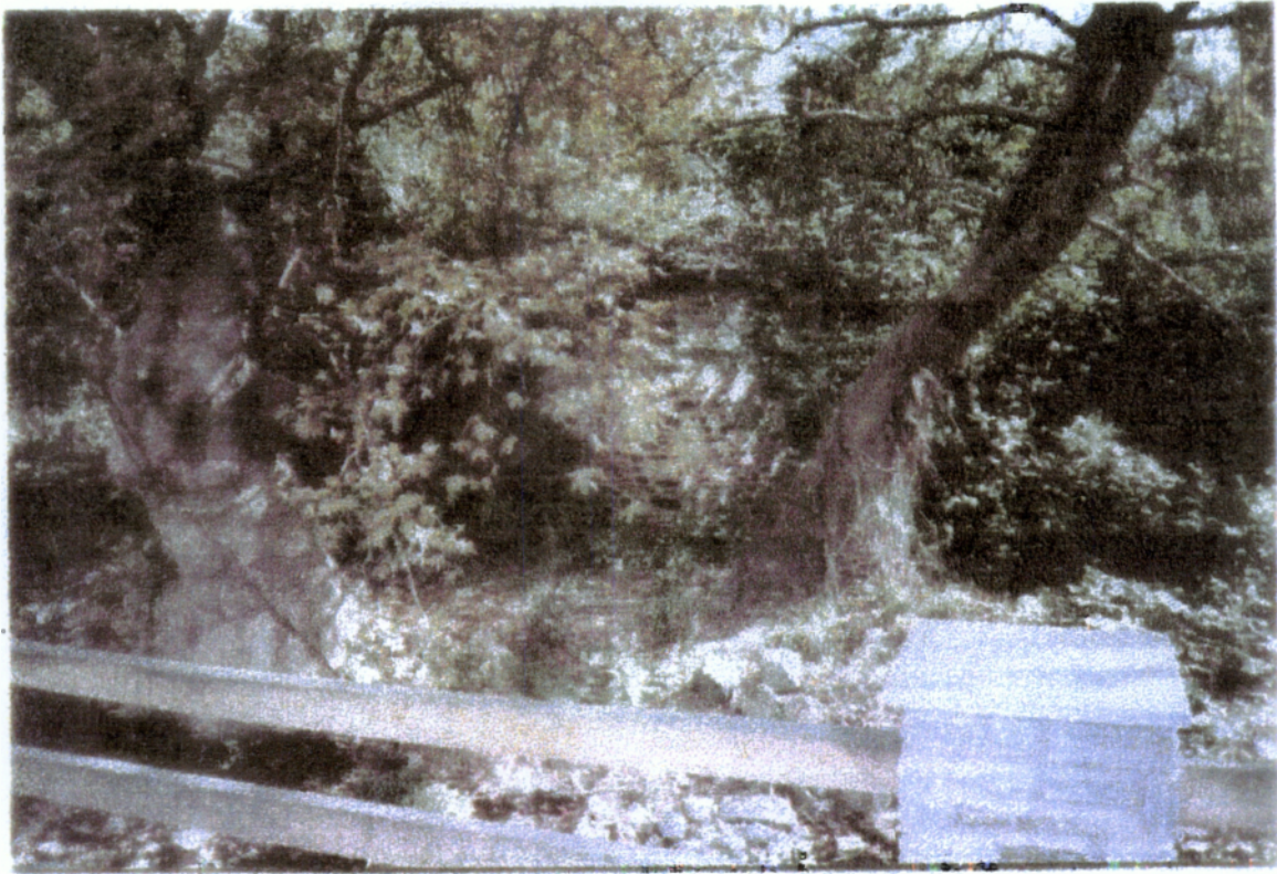
Φωτ 2.3.1 Ανάτλαση νερόμυλου στο ρέμα "Κοπλιτσός" στον οικισμό της Μ. Παναγιάς, δ.δ. Μ. Παναγιάς
