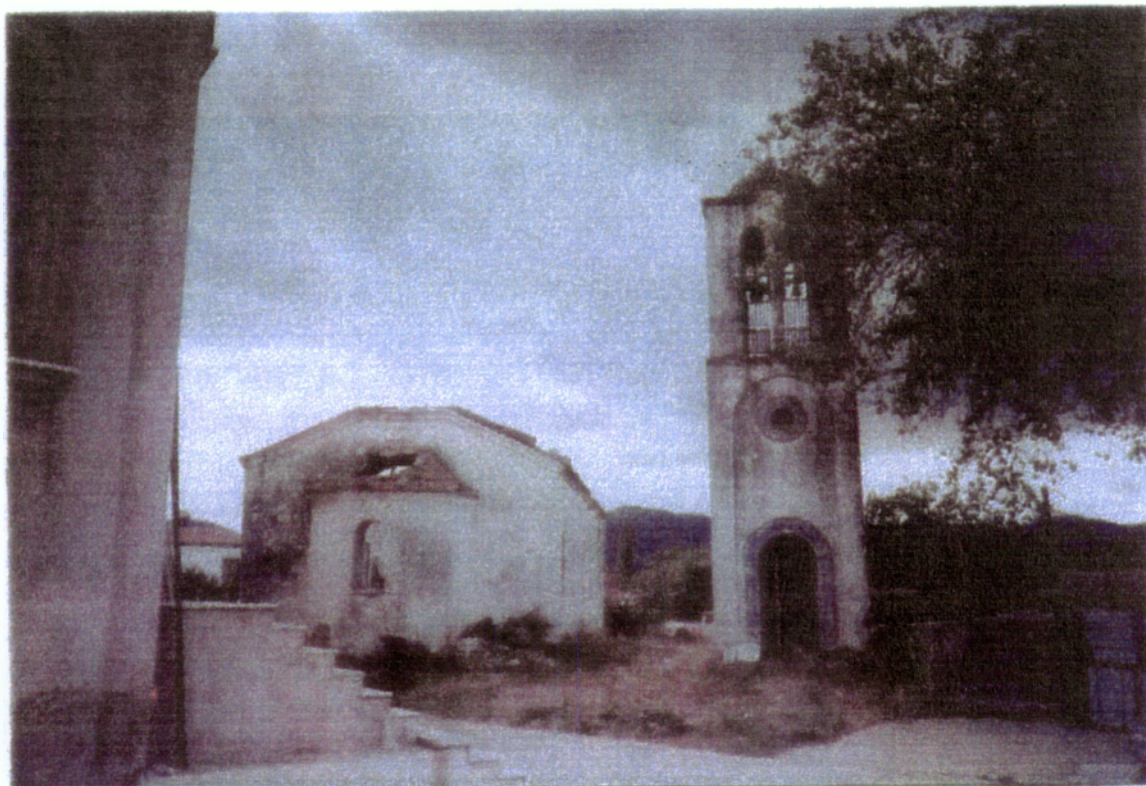
Φωτ 2.2.5. Ανακατασκευή και ανάπλαση περιβάλλοντα χώρου του Ι. Ν. Κοιμήσεως της Θεοτόκου στον οικισμό του Τοματίου δ.δ. Τοματίου
