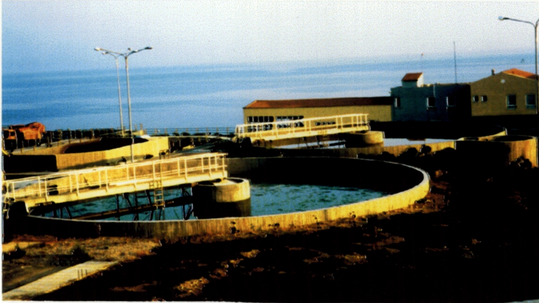
Εικόνα 3: Δεξαμενή πρωτοβάθμιας καθίζησης.
