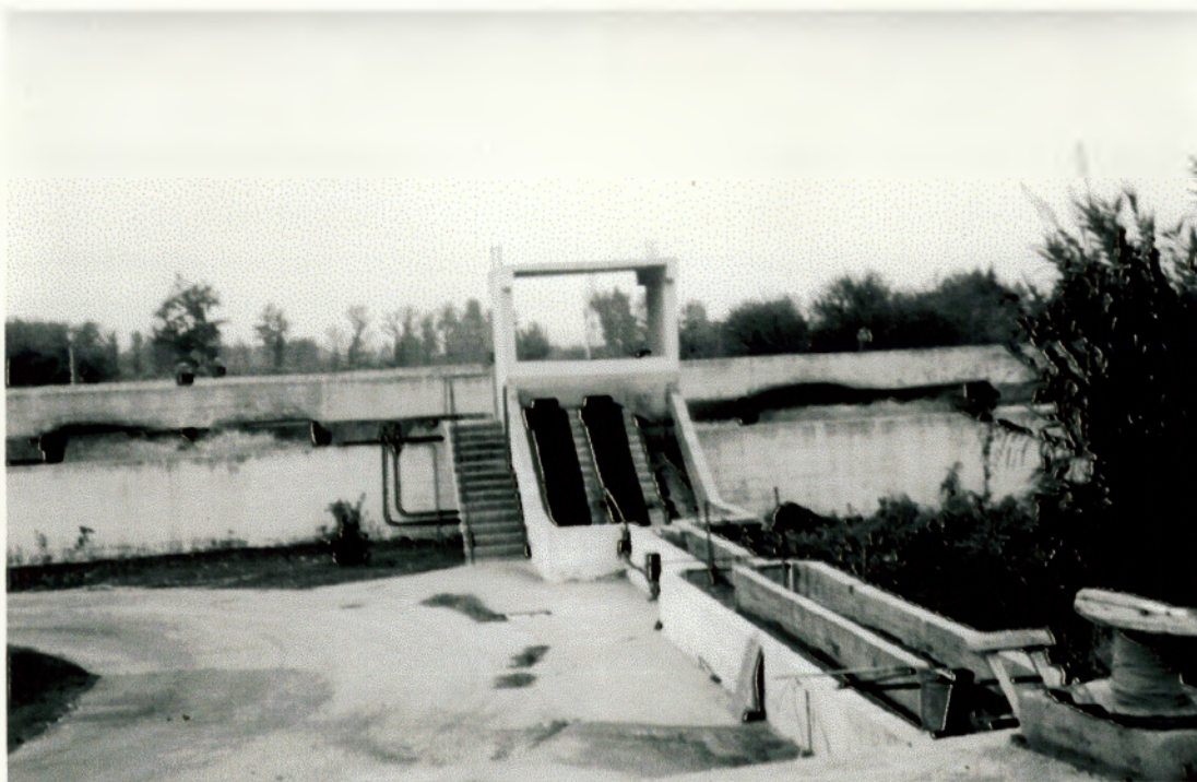
Εικόνα 6: Αντλιοστάσιο εισόδου στον κοχλία Αρχιμήδη.
