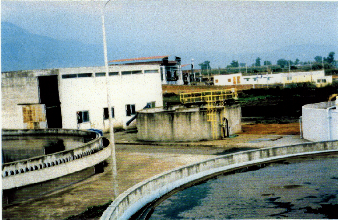
Εικόνα 9: Απεικόνιση δεξαμενών πρωτοβάθμιας καθίζησης.
