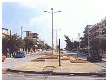
Ανάπλαση οδού Άστρος, στο Ίλιον
