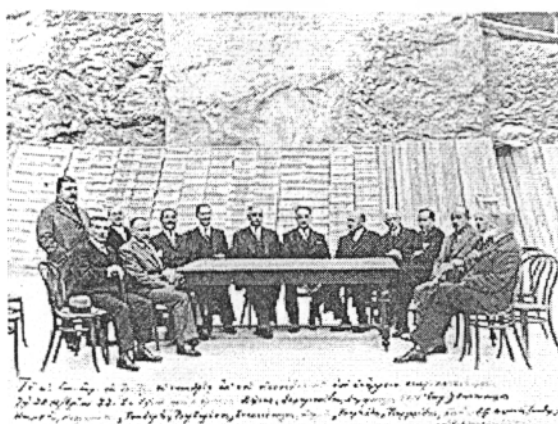
Εικόνα.1. Η Διοίκηση και τα μέλη του Γενικού Συμβουλίου συνεδριάζουν στις 20 Νοεμβρίου 1933, ημέρα της κατάθεσης του θεμέλιου λίθου, στην κατώτατη στάθμη των εκσκαφών. Από τα αριστερά προς τα δεξιά: Κ. Κουκούλης (Γραμματέας), Δ. Βαρλαμίδης, Δ. Νομικός, Κ. Κοσμετάτος, Μ. Πουρής, Γ. Σταματόπουλος, Κ. Βαρβαρέσσος, Ε. Τσουδερός, Μ. Νεγρεπόντης, Π. Καλλιγιάς, Δ. Κωστόπουλος, Α. Λαμπρόπουλος (Κ. Επίτροπος), Ε. Λαμπρινούδης, Σ. Δέλτας.
