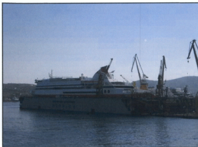
Άποψη του ναυπηγείου σήμερα. Διακρίνεται στην φωτό η πλώτη δεξαμενή Ν°1 με την ονομασία "Βιολαντώ Γουλανδρή"
