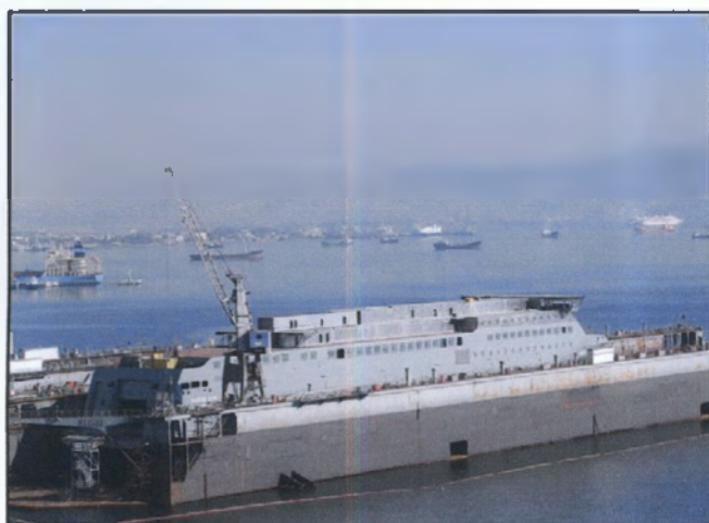
Το "Ήλιος Χίος" υπό κατασκευή στην πλωτή δεξαμενή των ναυπηγείων Ελευσίνος με συνολική ακιρότητα 35.000 τόνων
