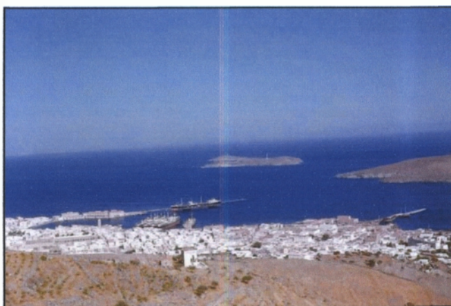
Φωτό από την δεκαετία του 1960. Δεξιά διακρίνεται η αρχική εγκατάσταση του ναυπηγείου. Αριστερά η κρατική πλωτή δεξαμενή
