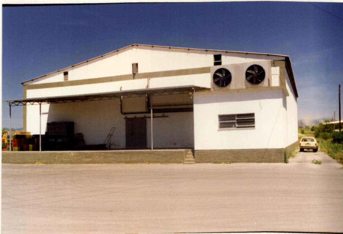
Εικόνα 14. Αποψη από το κτίριο του ψυγείου, ιδιοκτησίας Αθανασίου Παπαδόπουλου. Έτος ιδρύσεως 1972. Χωρητικότητας \approx 500 τόννων
