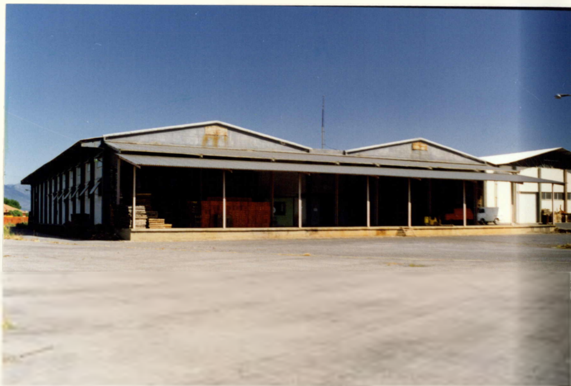
Εικόνα 1. Απόψη από το κτίριο του ψυγείου της Ε.Α.Σ.Α.
