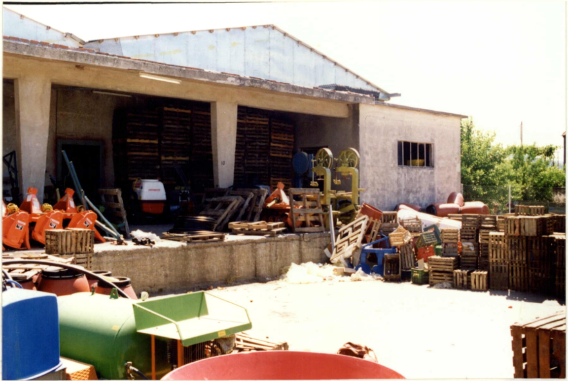
Εικόνα 10. Αποψη από το κτίριο του ψυγείου, ιδιοκτησίας Αφοι Δημητρόπουλοι. Έτος ιδρύσεως 1976. Χωρητικότητας \approx 1500 τόννων.
