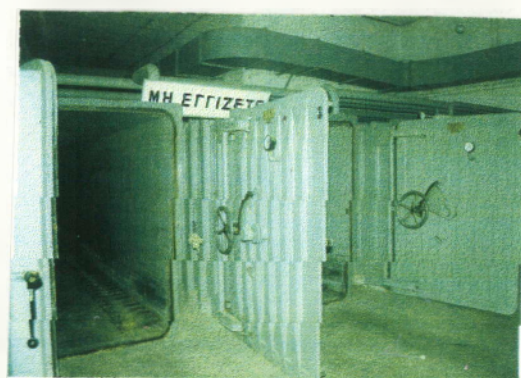
Αεροστεγείς θάλαμοι απεντόμωσης
