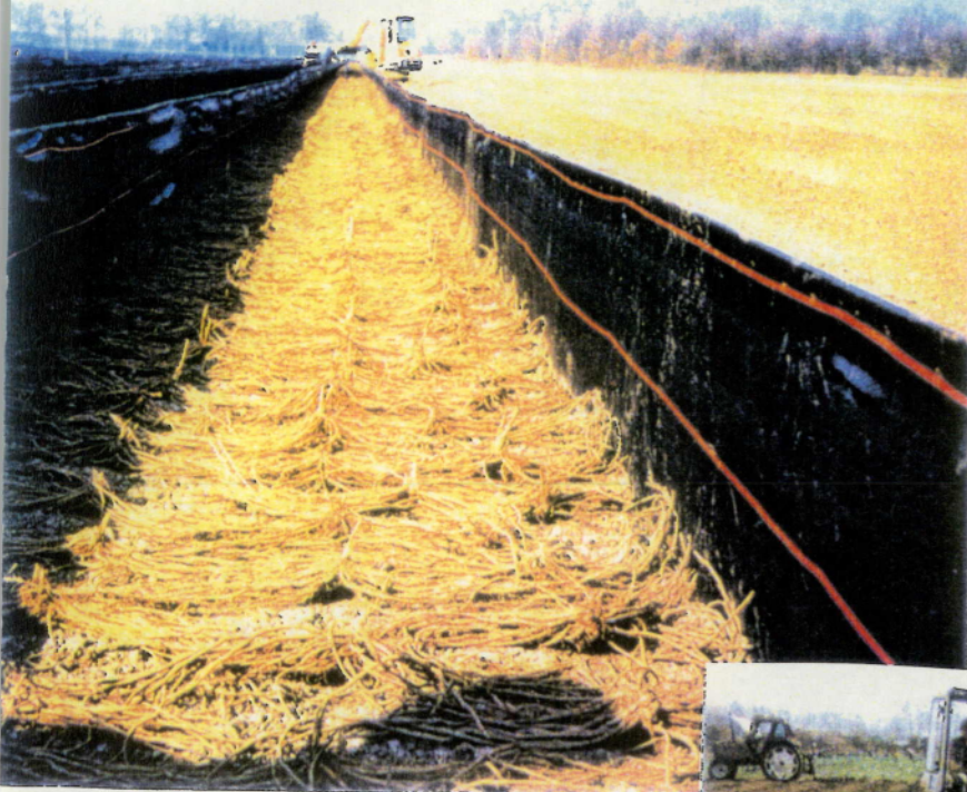
Εικ.ε.15 Φύτευση των ριζωμάτων στην "πρασιά"
