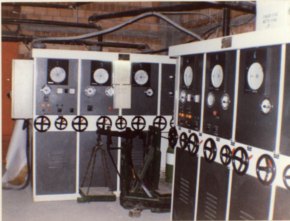
Εικόνα 2.11 Χίρποι αεριοφωγής (Vacuum) στα Κεντρικά αεριοφωγεία της ΣΥΚΙΚΗΣ
