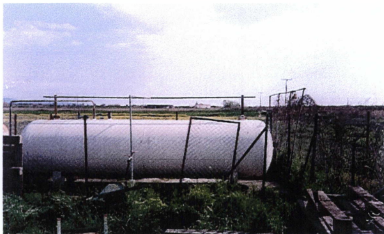
Εικόνα 49: Ο εφεδρικός λέβητας αερίου
