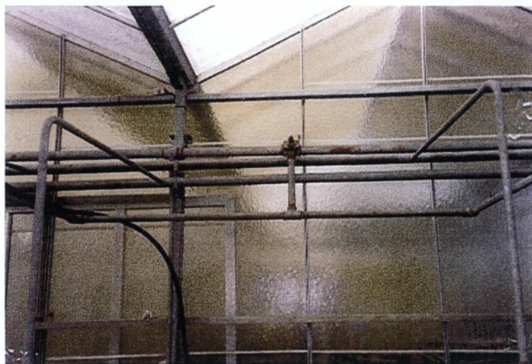
Εικόνα 56: Ηλεκτρομαγνητική βάνα 1 + \frac{1}{4} '' στους σωλήνες αρδέυσεως
