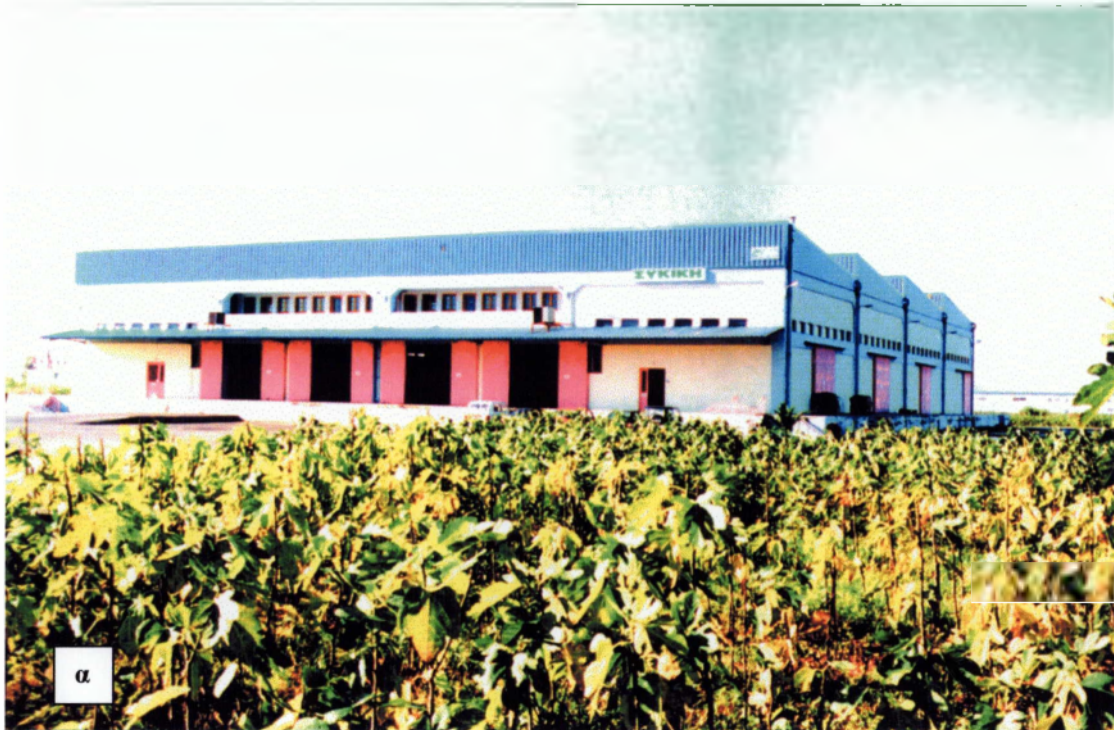
Φωτογραφία : α. Γενική άποψη εγκαταστάσεων και φυτωρίου της «ΣΥΚΙΚΗΣ» στη βιομηχανική περιοχή Καλαμάτας (Σπερχογεία).
