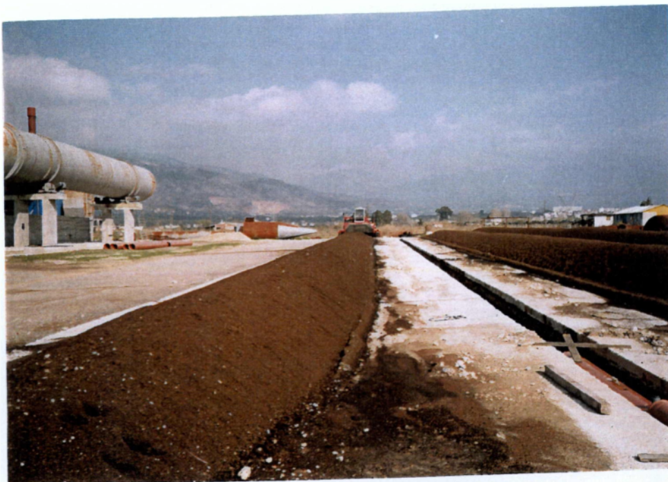
Εικόνα 3.18 & 3.19 Γενική άποψη του συστήματος σειραδίων (windrows) στην μονάδα της Καλαμάτας".
