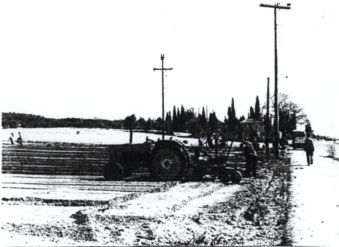
Φωτ. 10 : Μηχάνημα απλώματος. Στο βάθος φαίνεται η διαδικασία μοιράσματος των υλικών κατασκευής.
