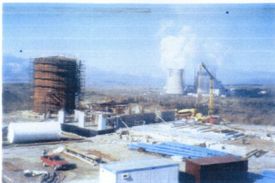
Εικόνα 2.4. Αρχική μορφή της απαλλοτριωμένης περιοχής για την εγκατάσταση του αντλιοστασίου και λεβητοστασίου
