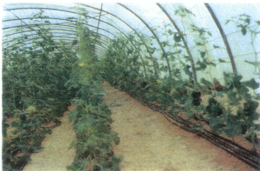
Εικόνα 1.3. Πλαστικοί σωλήνες σε πολλαπλές γραμμές κατά μήκος των γραμμών φύτευσης για θέρμανση με γεωθερμικό νερό.
