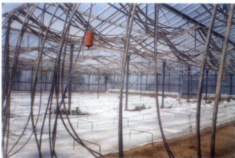
Εικόνα 3. Προετοιμασία θερμοκηπίου για την εγκατάσταση υδροπονικού συστήματος καλλιέργειας
