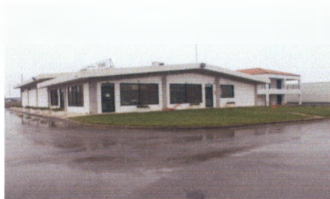
Εικόνα 7: Άποψη των γραφείων της μονάδας.
