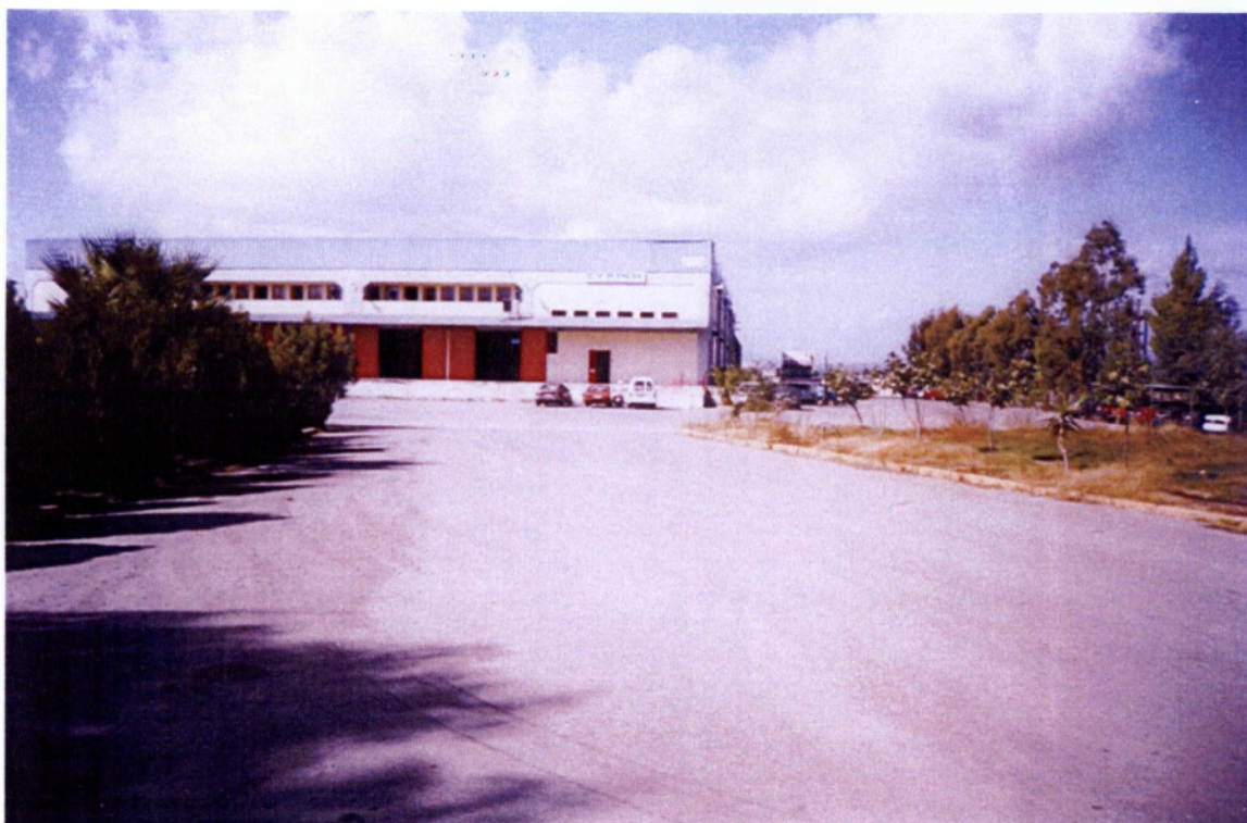
Φωτ. 24: Εργοστάσιο ΣΥΚΙΚΗΣ
