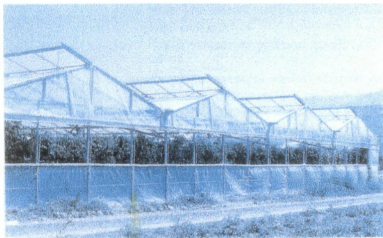
Παθητικός εξαερισμός με συνεχόμενα παράθυρα οροφής και πλευρικά
