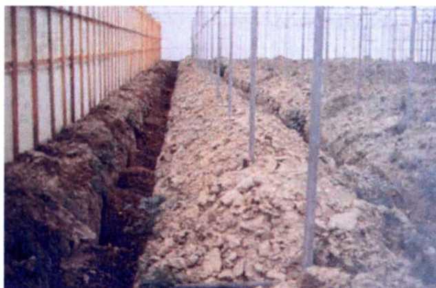
Εικόνα 9: Κατασκευή αποστραγγιστικού δικτύου σε θερμοκήπιο όπου θα καλλιεργηθεί μπανάνα
