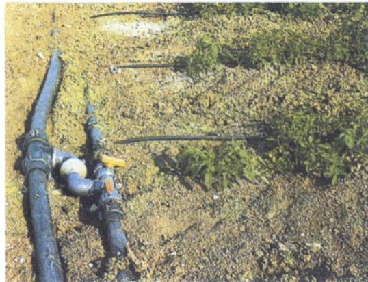
Εικ. 4.8 Σύνδεση στον κεντρικό αγωγό των σταλακτηφόρων σωλήνων.
