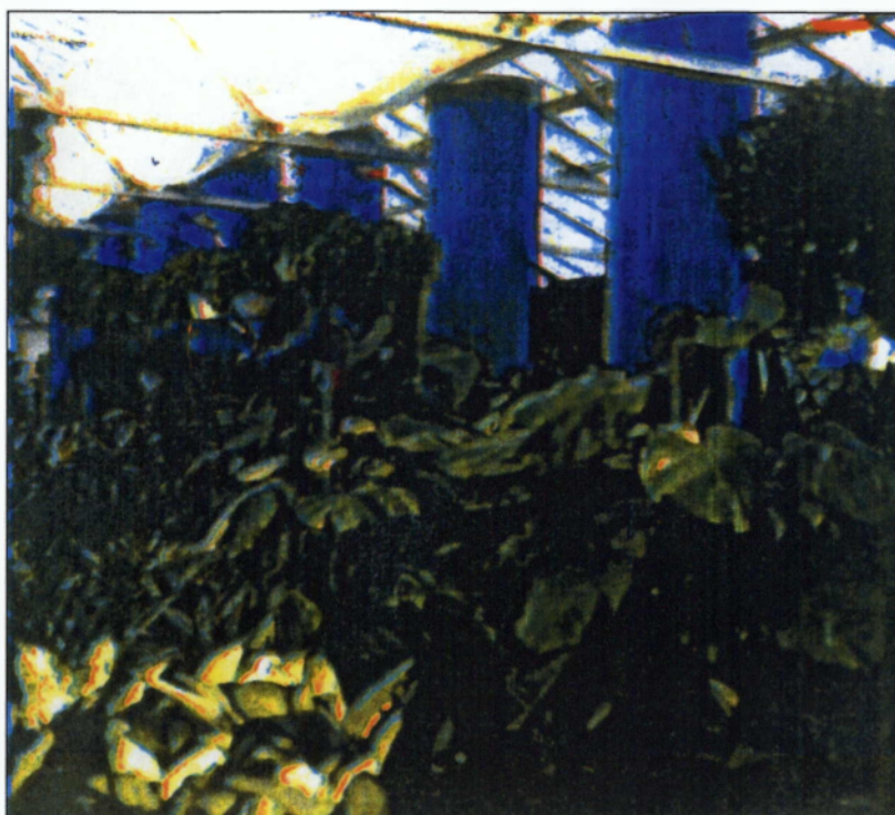
Εικόνα 28. Σωλήνες πολυαιθυλενίου γεμάτοι νερό για παθητική συλλογή και απόδοση της ηλιακής ενέργειας
