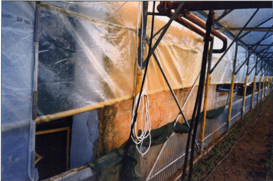
Εικόνα 22. Σωληνώσεις μεταφοράς του θερμού νερού θέρμανσης
