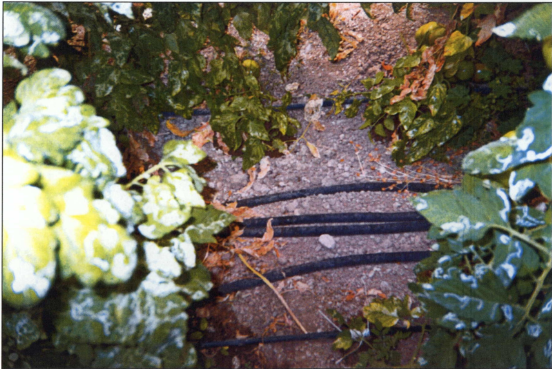
Εικόνα 14. Τμήμα χρήσης του συστήματος θέρμανσης του γεωθερμικού ρευστού
