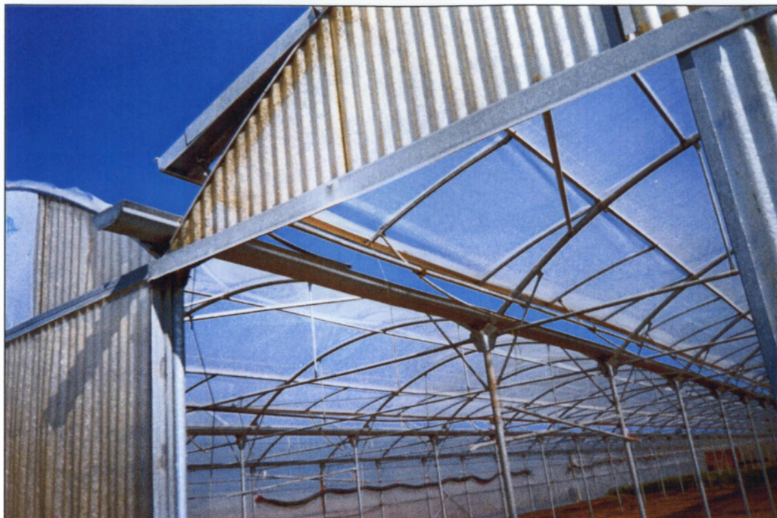
Εικόνα 3. Ανοιγμα εξαερισμού οροφής
