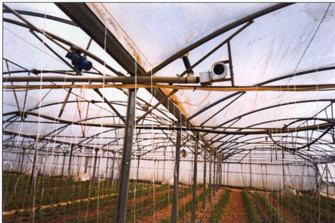
Εικόνα 4. Ανοιγμα εξαερισμού οροφής
