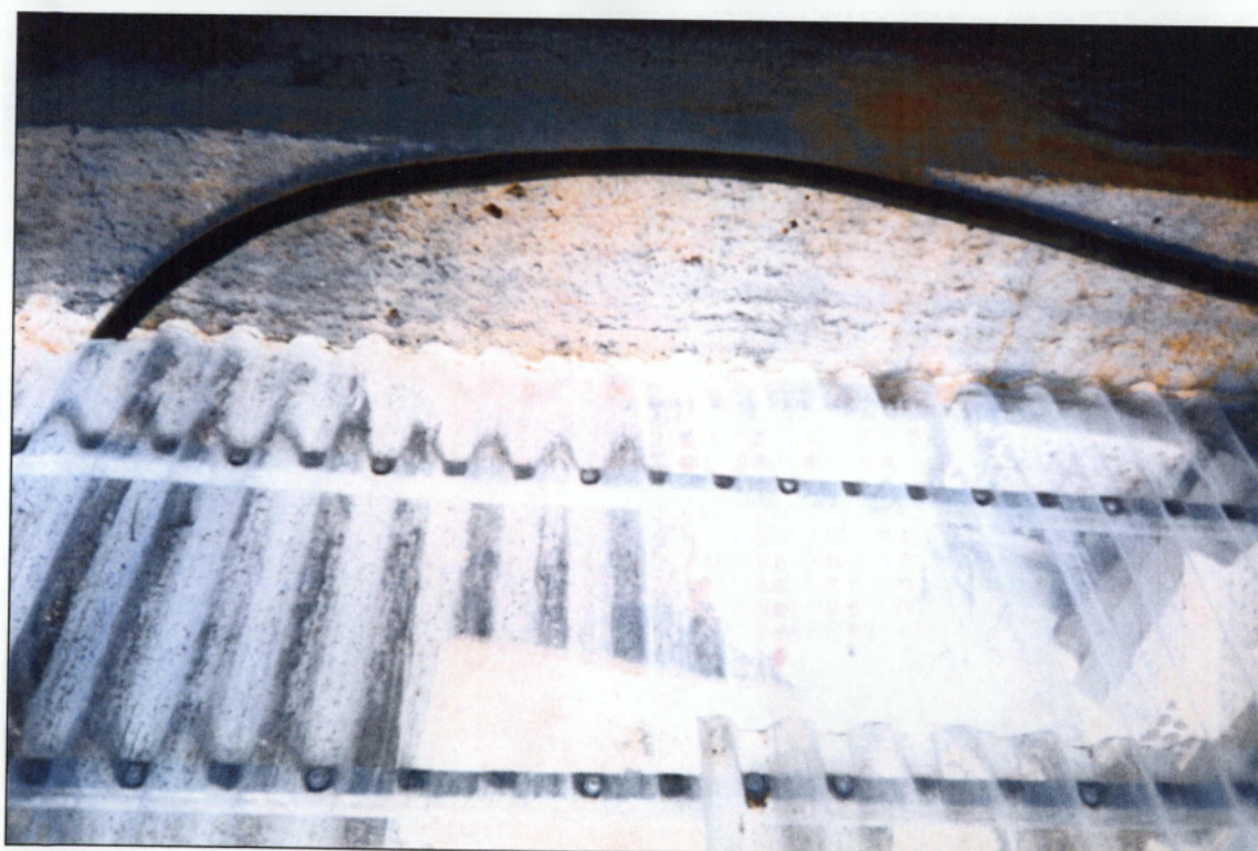
Εικόνα 10. Δεξαμενή - αποθήκη γεωθερμικού ρευστού
