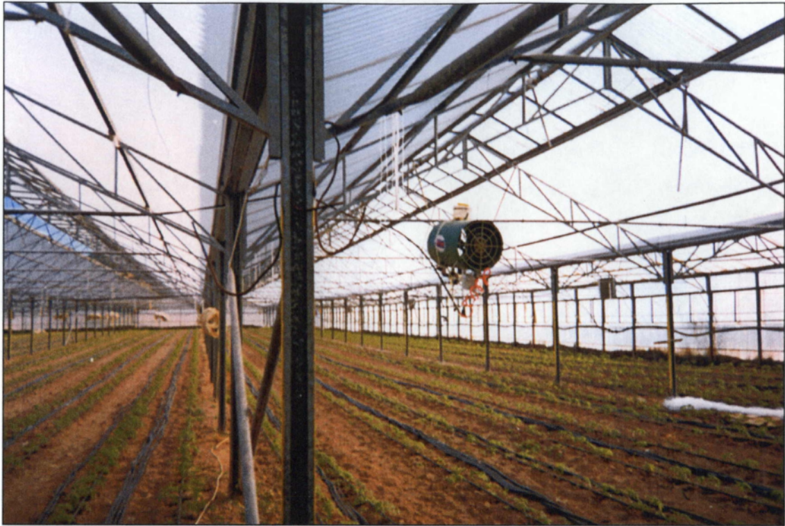
Εικόνα 13. Τμήμα χρήσης του συστήματος θέρμανσης του γεωθερμικού ρευστού
