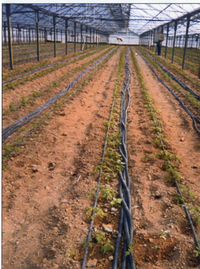
Εικόνα 16. Τμήμα χρήσης του συστήματος θέρμανσης του γεωθερμικού ρευστού
