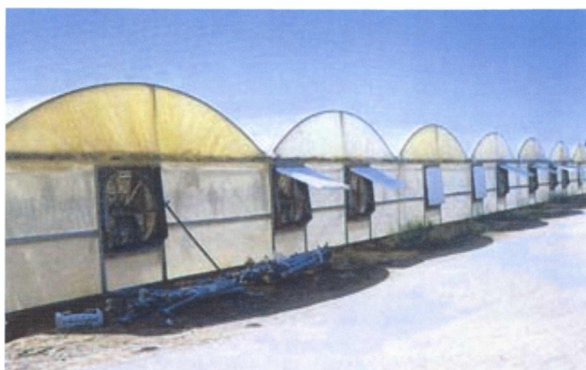
Εικ.3.13. Συστήματα δυναμικού εξαερισμού
