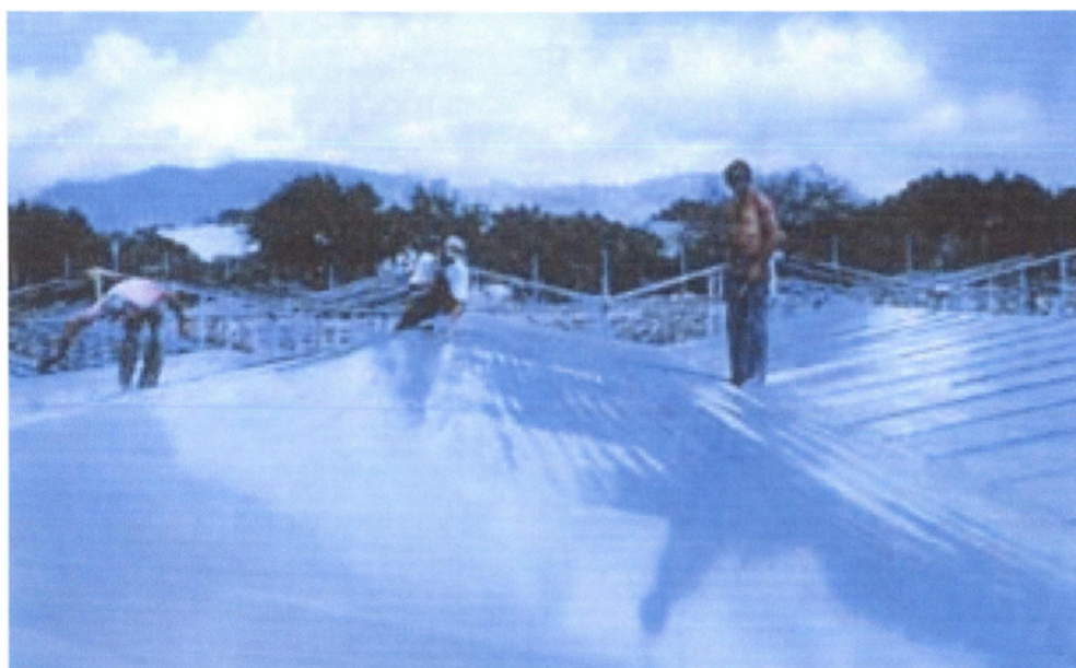
Εικ. 3.4. Τοποθέτηση φύλλων πολυαιθυλενίου
