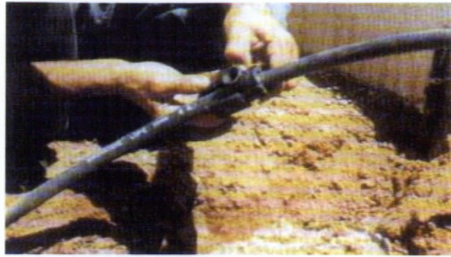
Εικόνα 5.4 Τοποθέτηση σέλας
