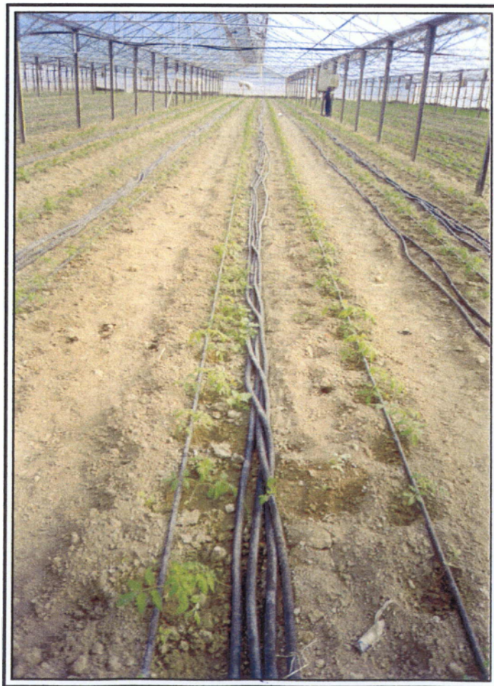
Εικ. 6. Τμήμα χρήσης του συστήματος θέρμανσης του γεωθερμικού ρευστού, με επιδαπέδιους σωλήνες, τύπου Geotherm.
