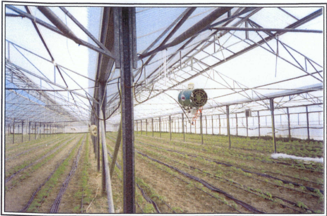
Εικ. 15. Εσωτερικό τοξωτού θερμοκηπίου με νεαρά φυτά τομάτας. Δεξιά φαίνονται και τα ανοίγματα οροφής.
