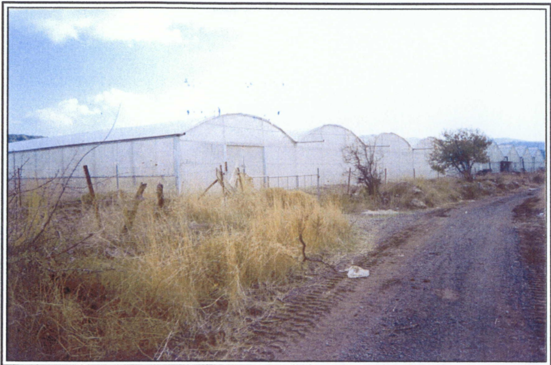
Εικ. 3. Μία εκ των τεσσάρων θερμοκηπιακών μονάδων. Σχήμα πολλαπλό, τοξωτό, με 4 κατασκευαστικές μονάδες.
