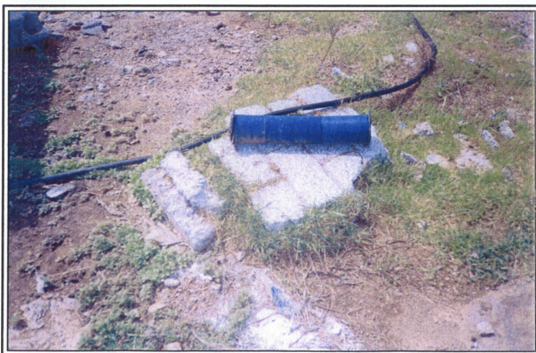
Εικ. 32. Φίλτρο καθαρισμού, έτσι όπως φαίνεται εσωτερικά.
