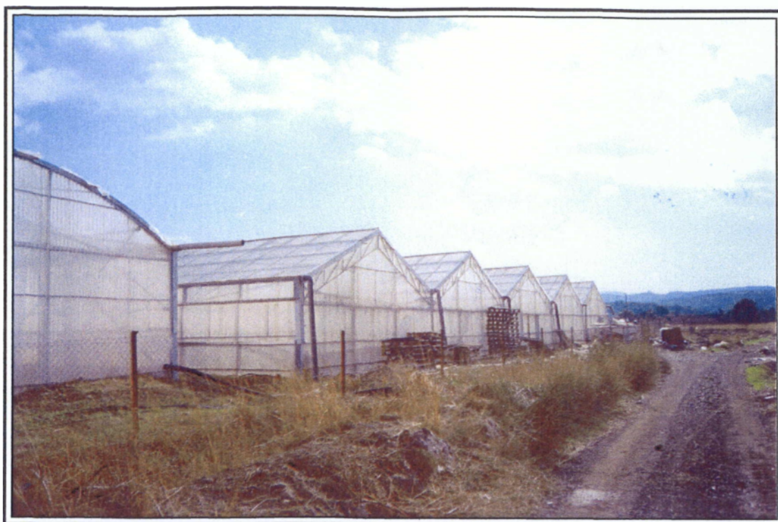
Εικ. 1. Μία εκ των τεσσάρων θερμοκηπιακών μονάδων. Σχήμα πολλαπλό, αμφικλινές, με 5 κατασκευαστικές μονάδες.
