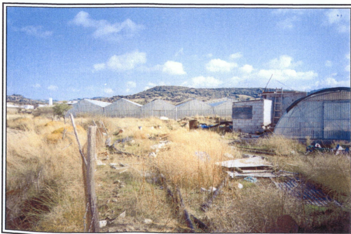
Εικ. 2. Μία εκ των τεσσάρων θερμοκηπιακών μονάδων. Σχήμα πολλαπλό, αμφικλινές, με 5 κατασκευαστικές μονάδες.
