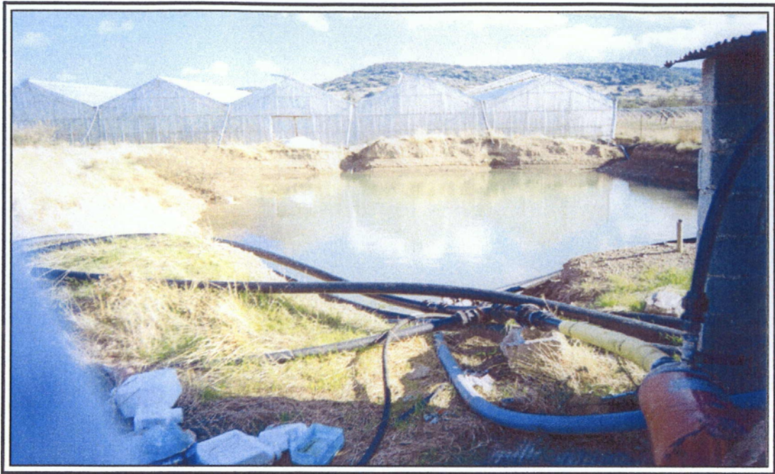
Εικ. 9. Ανοιχτή χωμάτινη ομβροδεξαμενή.
