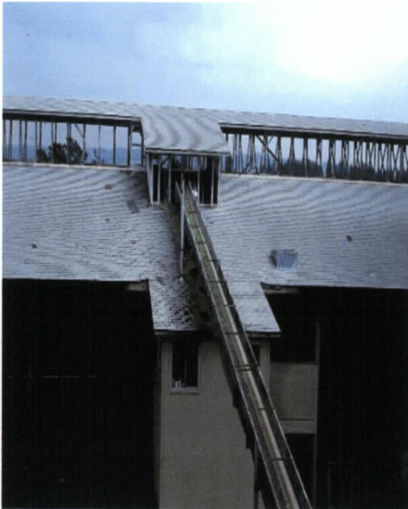
Εικόνα 3.30 Ταινιόδρομος μεταφοράς των κώνων στον χώρο ξήρανσης.
