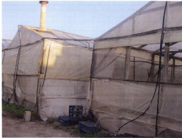
Εικόνα 1. Εξωτερική όψη των θερμοκηπίων όπου παρατηρούνται τα πλαϊνά παράθυρα στα οποία έχουν τοποθετηθεί σήτες.
