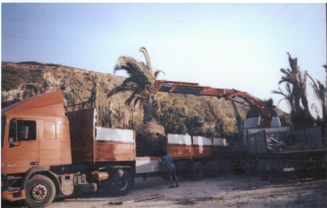
Εικ. 43: Τοποθέτηση φοινικόδενδρων στον τόπο φύτευσης
