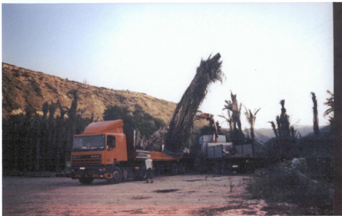
Εικ. 40: Τοποθέτηση φοινικόδενδρων στον τόπο φύτευσης
