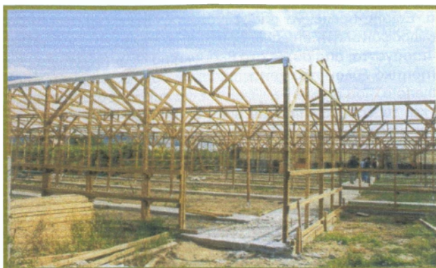
Εικόνα 25. Σκελετός θερμοκηπίου από εμποτισμένο ξύλο. Πηγή: (Θερμοκήπιο, Γ.Ν. Μαυρογιαννόπουλου)
