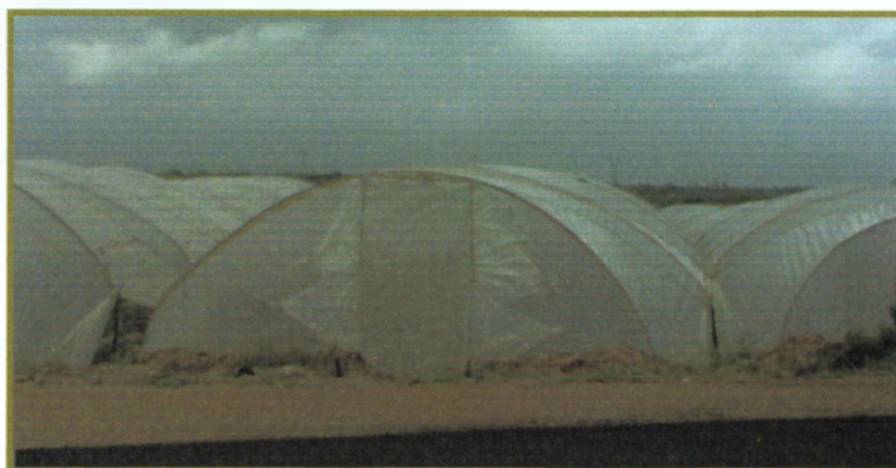
Εικόνα 29. Τροποποιημένο απλό τοξωτό θερμοκήπιο, από υλικό κατασκευής σίδηρο και υλικό κάλυψης πλαστικό πολυαιθυλαίνιο.
