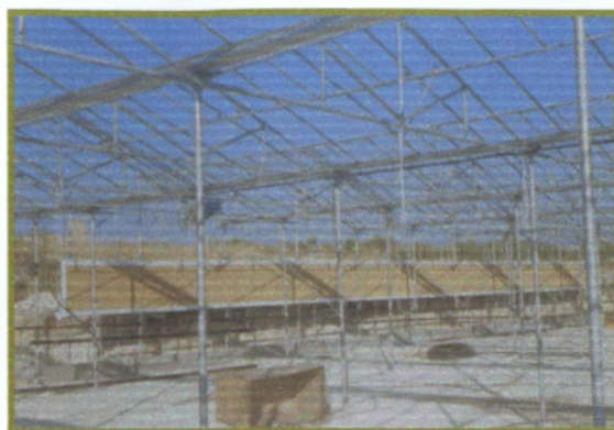
Εικόνα 26. Κατασκευή θερμοκηπίου με μεταλλικό σκελετό. Πηγή: (Θερμοκήπιο, Γ.Ν. Μαυρογιαννόπουλου)
