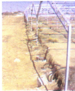
Εικόνα 14: εγκατάσταση δικτύου στράγγισης
