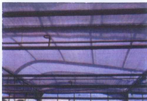
Εικόνα 16: δίκτυο δροσισμού τύπου ομίχλης
