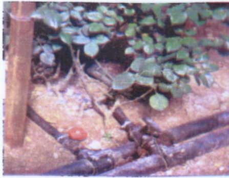
λεπτομέρεια αρδευτικού συστήματος
