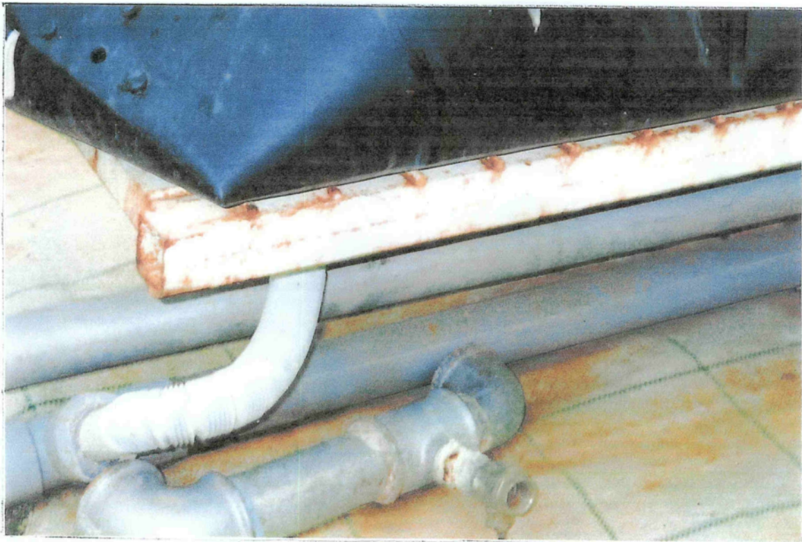
Εικόνα 16: Σωλήνες απορροής και Σωλήνες θέρμανσης
