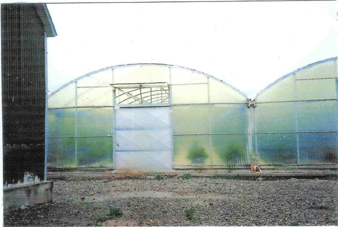
Εικόνα 1: Τροποποιημένο τοξωτό θερμοκήπιο (πόρτα - παράθυρο - υδρορροή)
