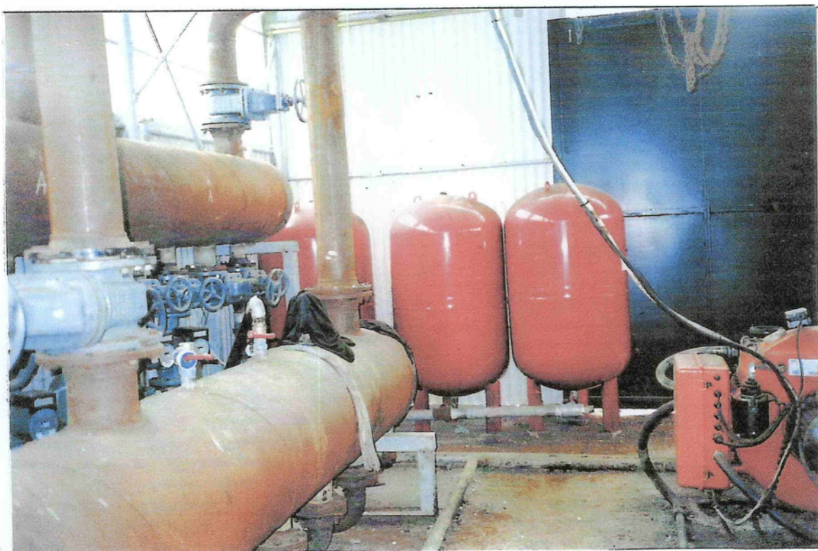
Εικόνα 8: Μπόιλερ – Κομπλετέρ – Κυκλοφορητής
