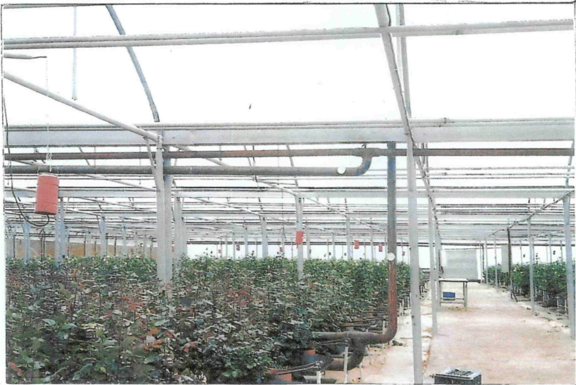
Εικόνα 17: Εσωτερικό τροποποιημένου τοξωτού ( κεντρικός διάδρομος, σωλήνες θέρμανσης, ψεξαστήρες, υγρό τοίχωμα)
