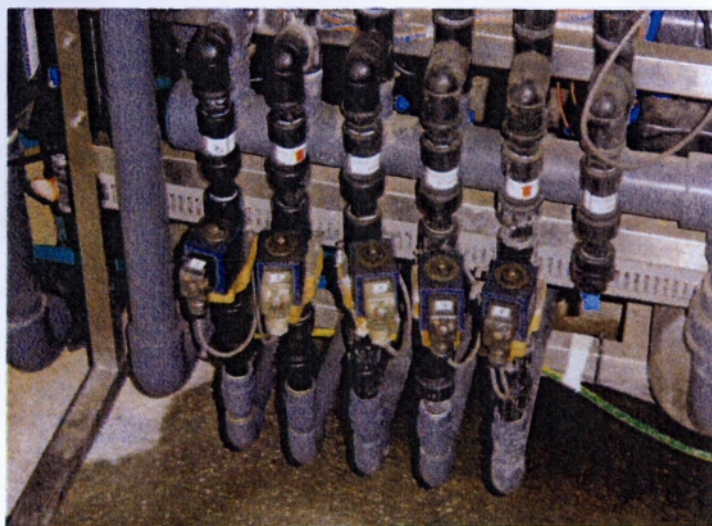
Εικόνα 21. Οι ηλεκτροβάνες για τον καθορισμό των στάσεων άρδευσης
