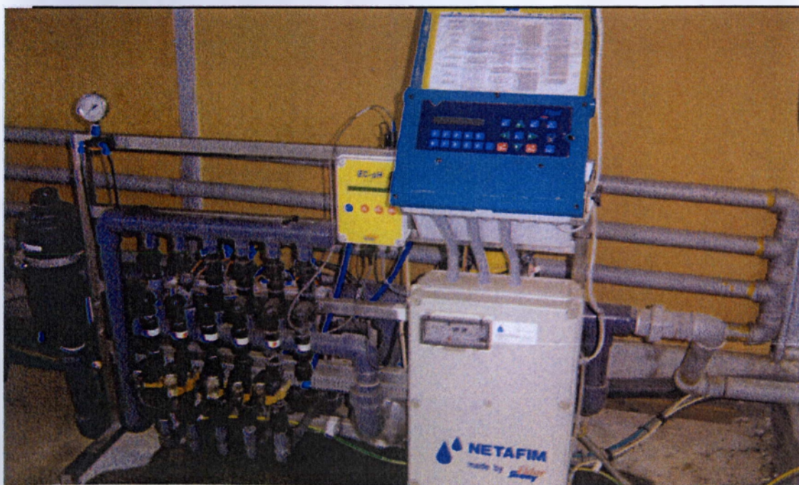
Εικόνα 16. Ο "εγκέφαλος" του συστήματος άρδευσης. Διακρίνουμε τις ηλεκτροβάνες, το pHμέτρο και την κεντρική κονσόλα του μείκτη λιπασμάτων.
