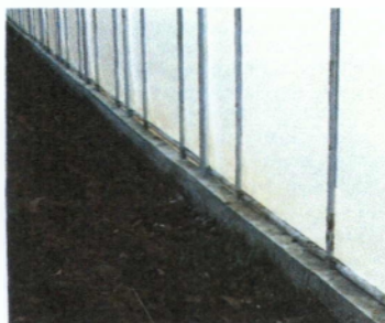
Εικ. 6.2. Σκυρόδεμα περιμετρικά του θερμοκηπίου (Γεωργία – Κτηνοτροφία, 1999).
