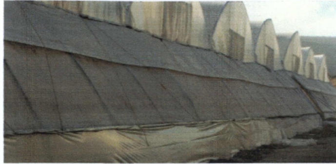
Εικ. 4.6. Τοποθέτηση εντομοστεγών δικτύων στο θερμοκήπιο (Γεωργία - Κτηνοτροφία, 2002).
