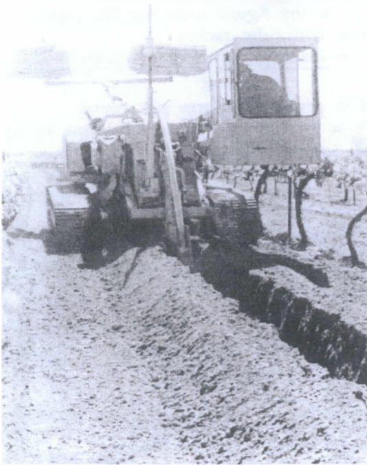
4.5:Σκαπτικά μηχανήματα που χρησιμοποιούνται για την εγκατάσταση σωληνώσεων στράγγισης σε αμπελώνες.
