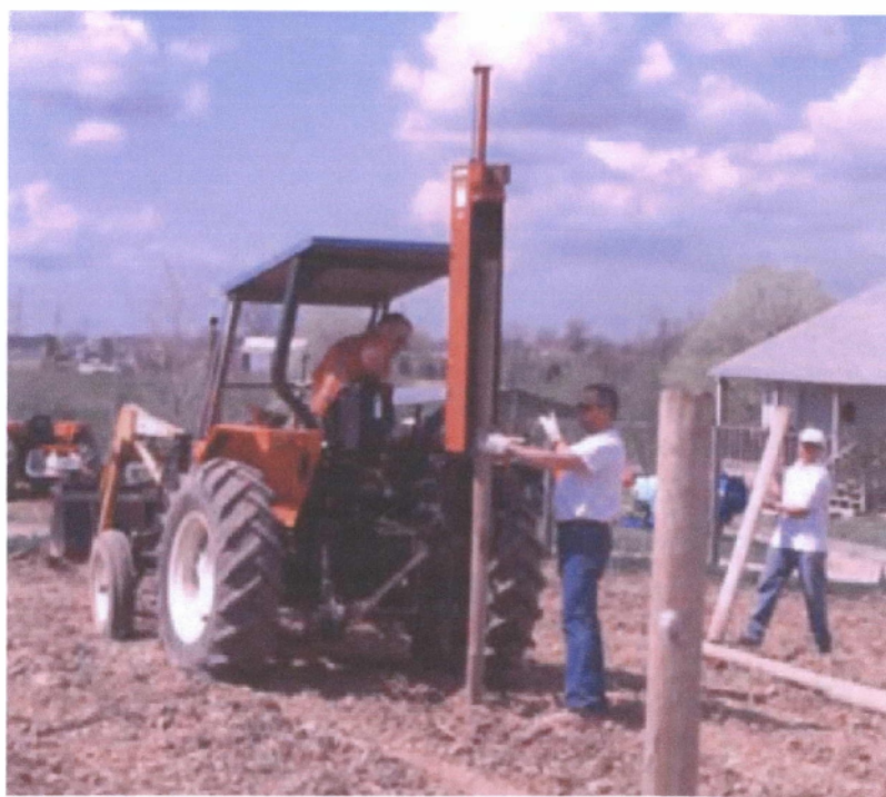
Εικ3.8: Τοποθέτηση των πασσάλων υποστήριξης για τις αμπέλους.
