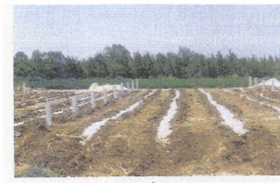
Εικ. 2.2 Στραγγιστικό δίκτυο με πλαστικούς διάτρητους σωλήνες
