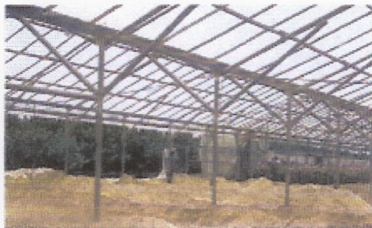
Εικ 2.1 Αντικατάσταση χώματος θερμοκηπίου
