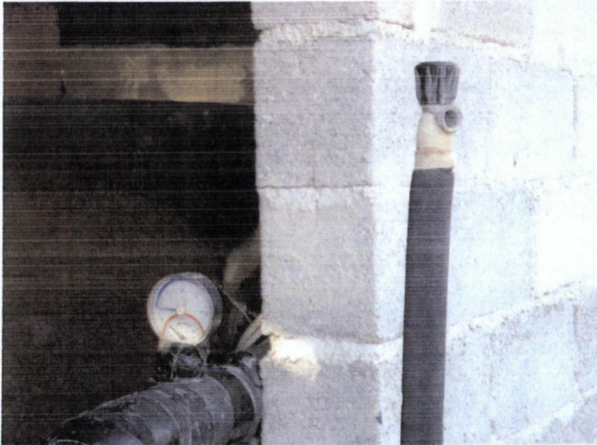
Εικ. 4.35 Δεξιά είναι η βαλβίδα εξαερισμού και αριστερά το όργανο που μας δείχνει την θερμοκρασία.
