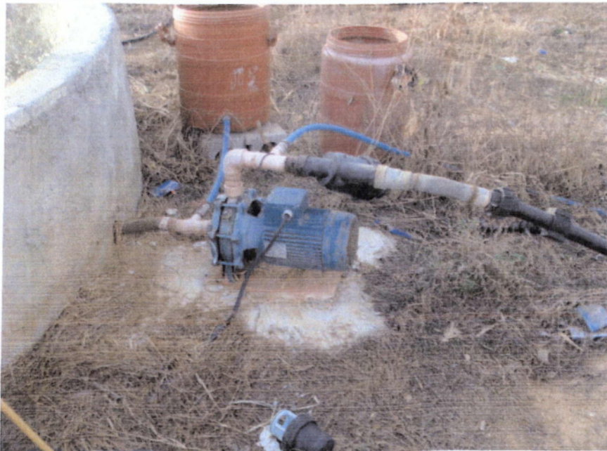
Εικ. 4.17 Η αντλία, η κεφαλή άρδευσης (ο λιπαντήρας και το φίλτρο) και συνδέονται με τον υπόγειο αγωγό άρδευσης.
