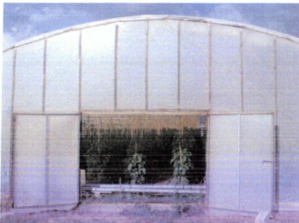
Εικ. 4.4 Εμπρόσθια πλευρά του θερμοκηπίου
