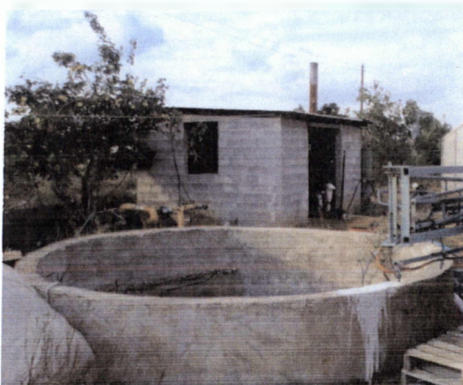
Εικ. 4.14 Δεξαμενή νερού (πηγάδι)
