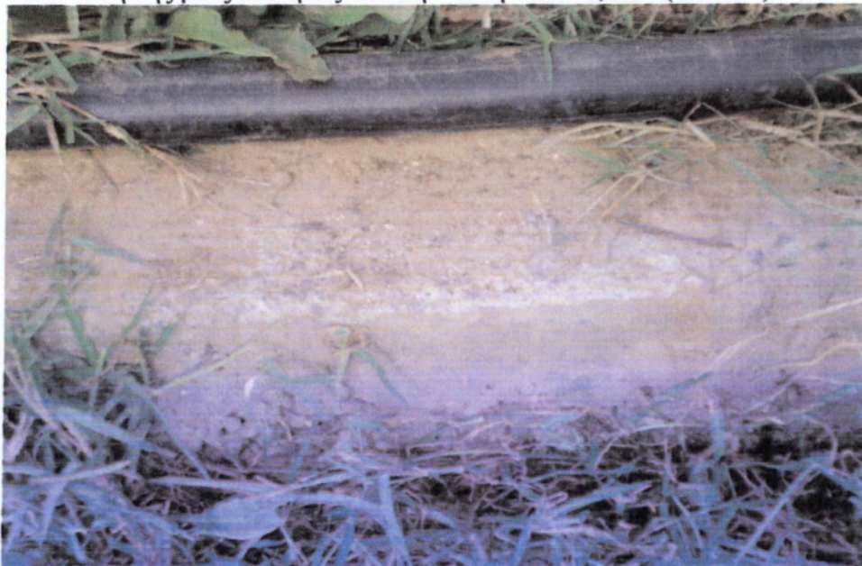
Εικ. 4.2 Η ζώνη με οπλισμένο σκυρόδεμα που υπάρχει περιμετρικά του θερμοκηπίου.
