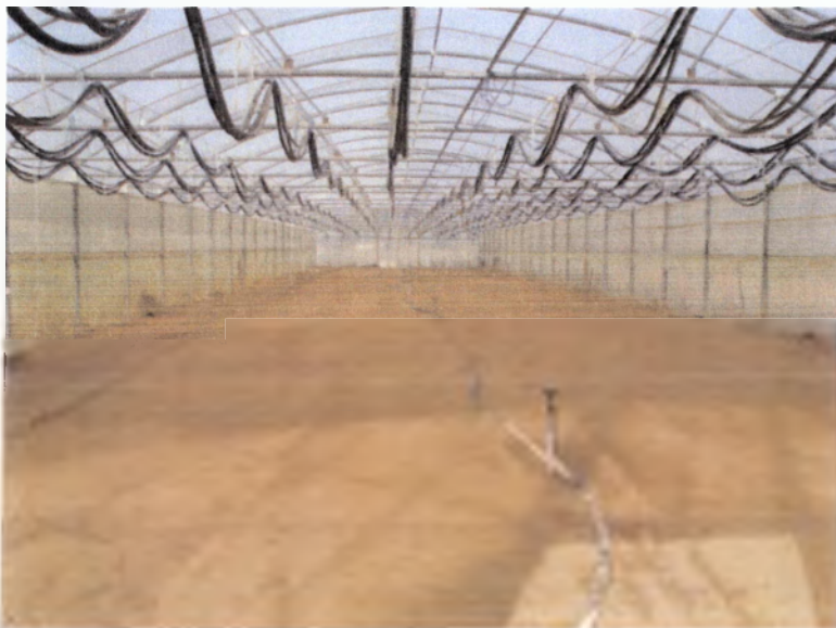
Εικ. 4.12 Το έδαφος του θερμοκηπίου απαλλαγμένο από ζιζάνια, οι σωλήνες ποτίσματος και θέρμανσης είναι δεμένες ψηλά πάνω στις αωλήνες και το θερμοκήπιο παραμένει κλειστό για απολύμανση (20 ημέρες).
