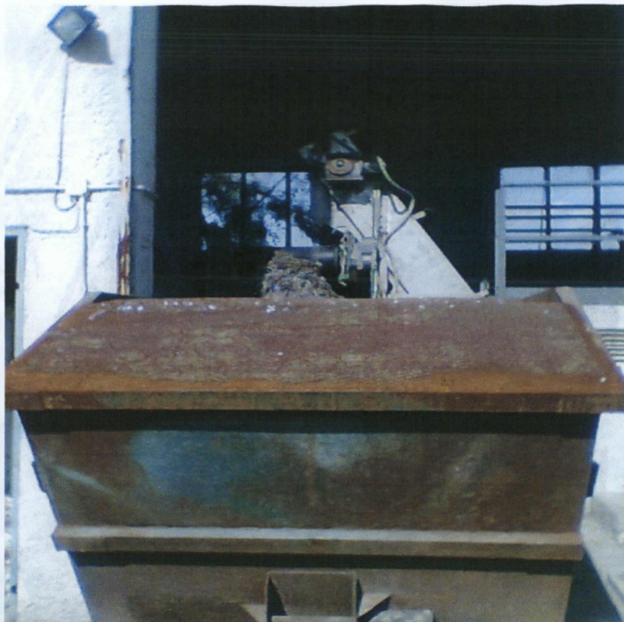
Εικόνα 4.2.2 Εγκαταστάσεις εσχαρισμού
