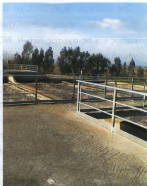
Εικόνα 4.2.12 Δεξαμενή παρατεταμένου αερισμού
