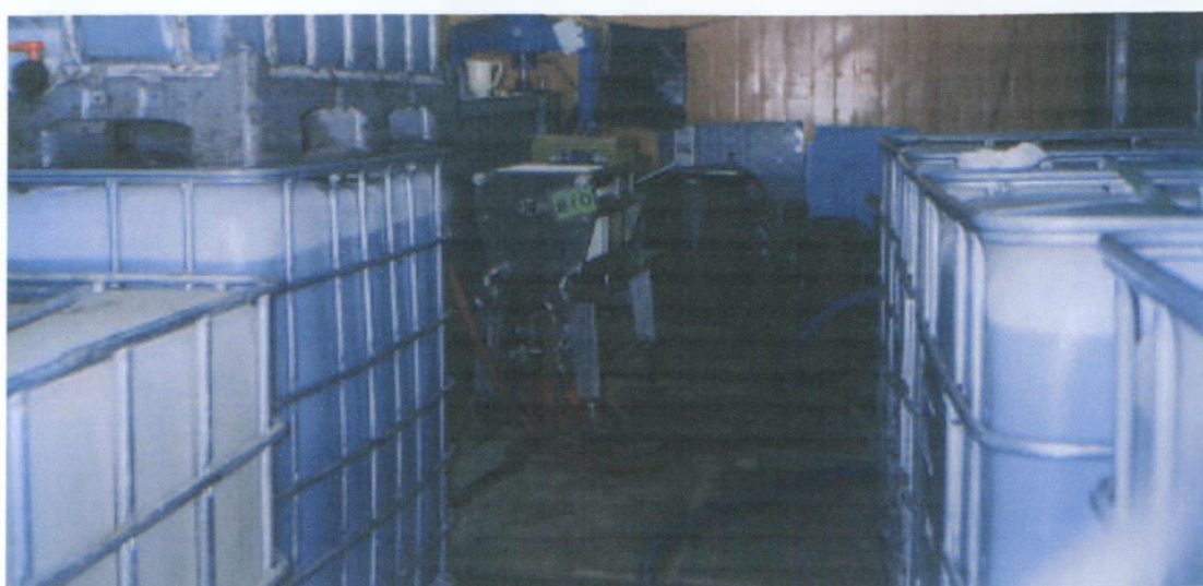
Εικόνα 57: στο βάθος μηχάνημα φιλτραρίσματος ελαιολάδου. Μπροστά πλαστικές δεξαμενές τοποθέτησης του ελαιολάδου μετά το φιλτράρισμα
