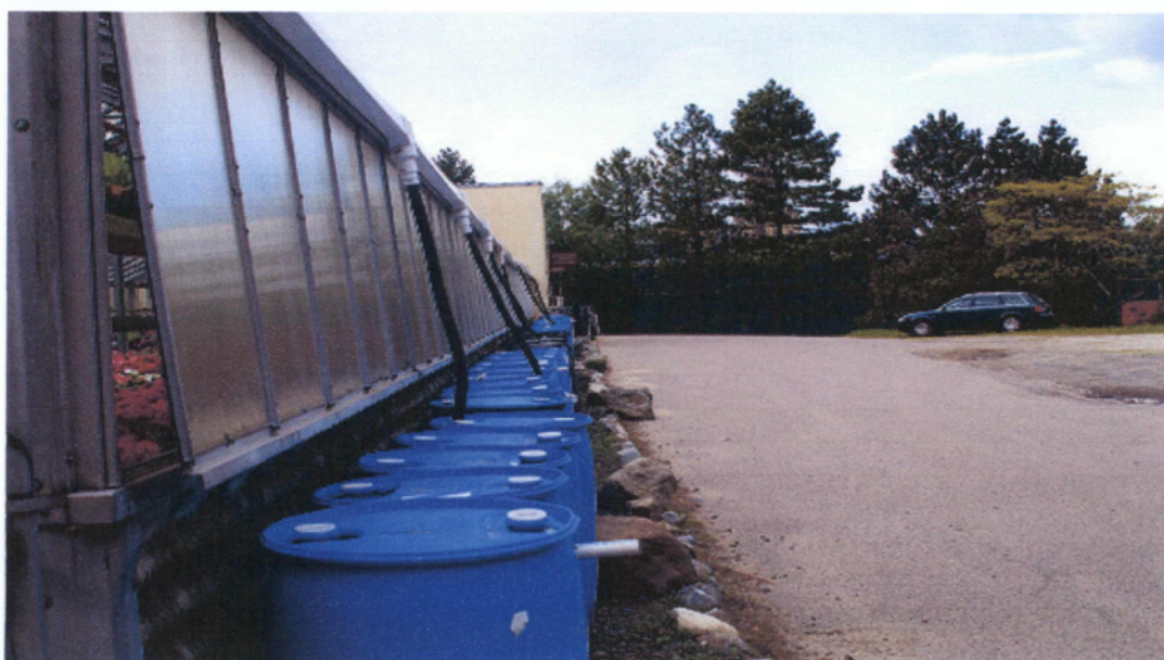
Εικόνα 2: Βαρέλια διανομής νερού θερμοκήπιο
