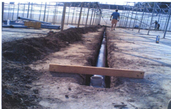
Εικόνα 21: Κεντρικός αγωγός δικτύου απορροής
