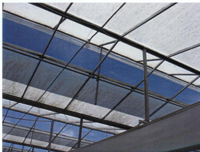
Εικ. 37: Ανοίγματα οροφής στο θερμοκήπιο
