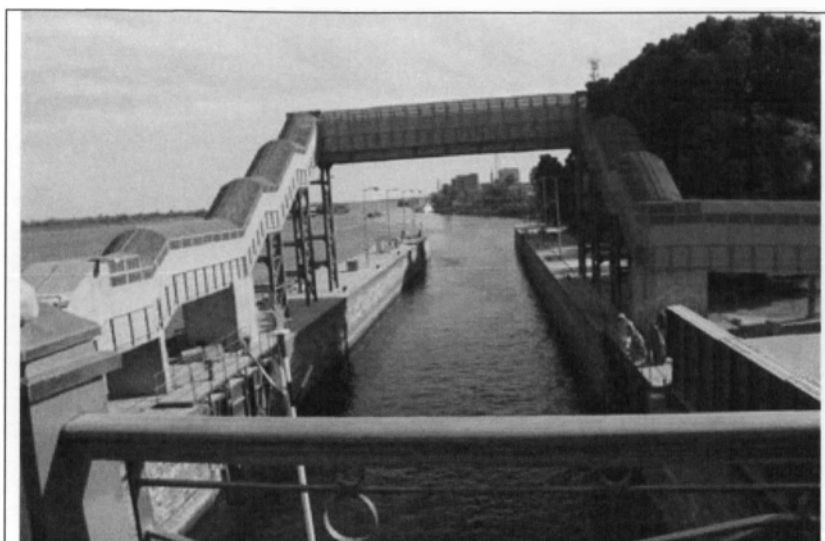
Εικόνα 2.11. Σύγχρονο φράγμα (υδροφράκτης) Έσσα του Νείλου.
