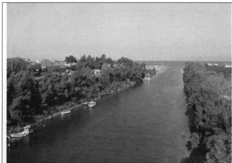
Εικόνα 3.1. Διώρυγα μεταφοράς αρδευτικού νερού.
