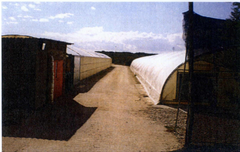
εικόνα 8 Αριστερά χώρος λεβητοστάσιου ΓΕΩΘΕΡΜ Α.Ε
