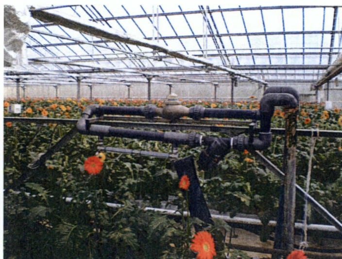
εικόνα 16 Μηχάνημα απορροής (ΓΕΩΘΕΡΜ Α.Ε)
