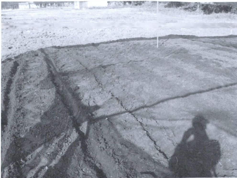
Εικόνα 2. Προετοιμασία πειραματικού αγρού: ισοπέδωση εδάφους
