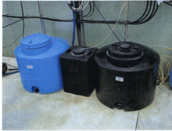
Εικόνα 2.5: Δεξαμενές πυκνών διαλυμάτων
