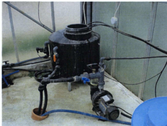
Εικόνα 2.4 Δεξαμενή συλλογής θρεπτικού διαλύματος
