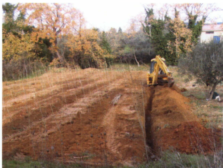
Εικόνα 21: Πιλοτική διάθεση υγρών αποβλήτων ελαιοτριβείων για άρδευση δέντρων (“φυτοεξυγίανση”) στην περιοχή Βασιλάκι Λακωνίας
