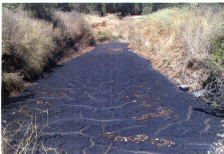
Εικόνα 20: Υγρά απόβλητα ελαιοτριβείου σε δεξαμενή καθίζησης
