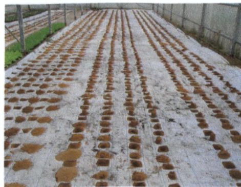
Εικόνα 2.5. Τοποθέτηση πανιού εδαφοκάλυψης σε όλη την επιφάνεια του θερμοκηπίου.
