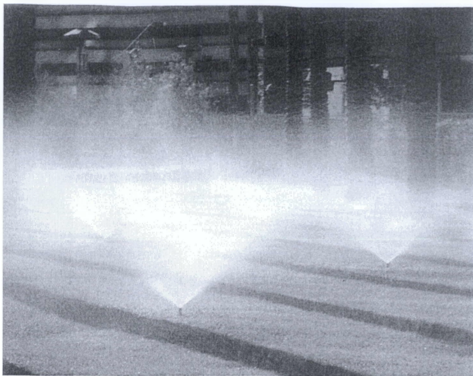
Εικόνα 32. Άρδευση χλοοτάπητα με στατικούς αυτοανυψούμενους υπόγειους εκτοξευτήρες (τύπου pop - up) (Πηγή: WEATHERMATIC)
