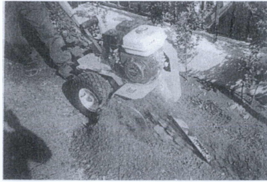
Εικόνα 74. Μηχανική διάνοιξη χαντακιών
